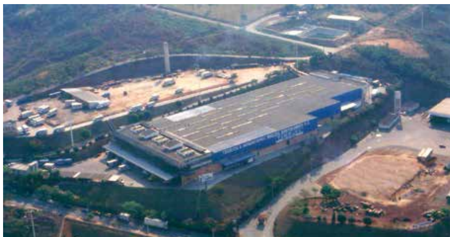
Vista aérea das instalações iniciais em Contagem
