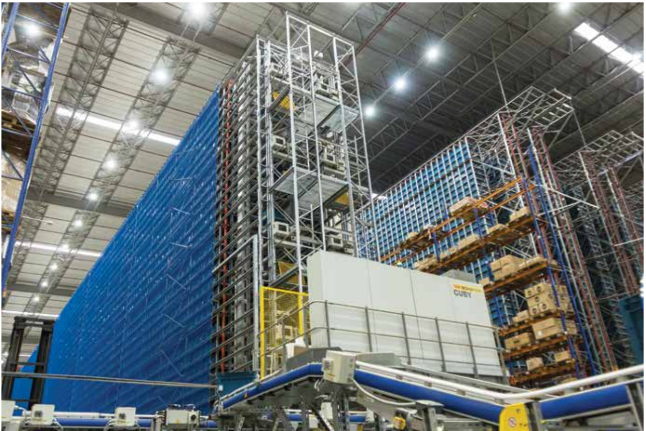
Modernas instalações em um galpão com pé direito de 24 metros
