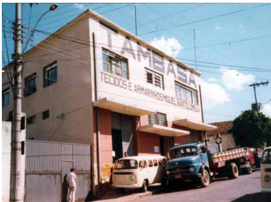
Instalações da Rua Peçanha
