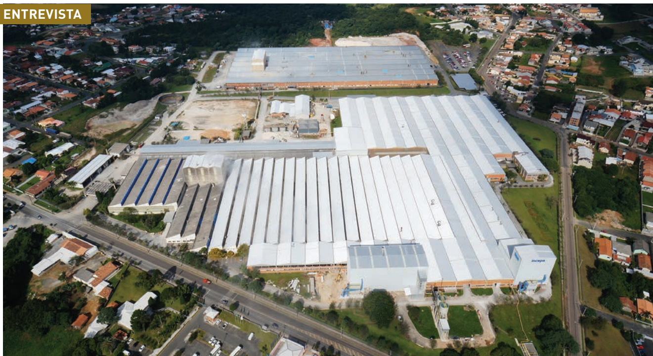
Vista aérea da fábrica da Roca Cerâmica em Campo Largo, Paraná
